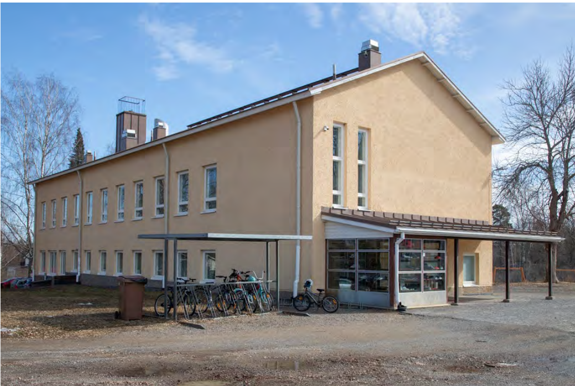
Luopioisten vuonna 1954 rakennettu koulurakennus.
