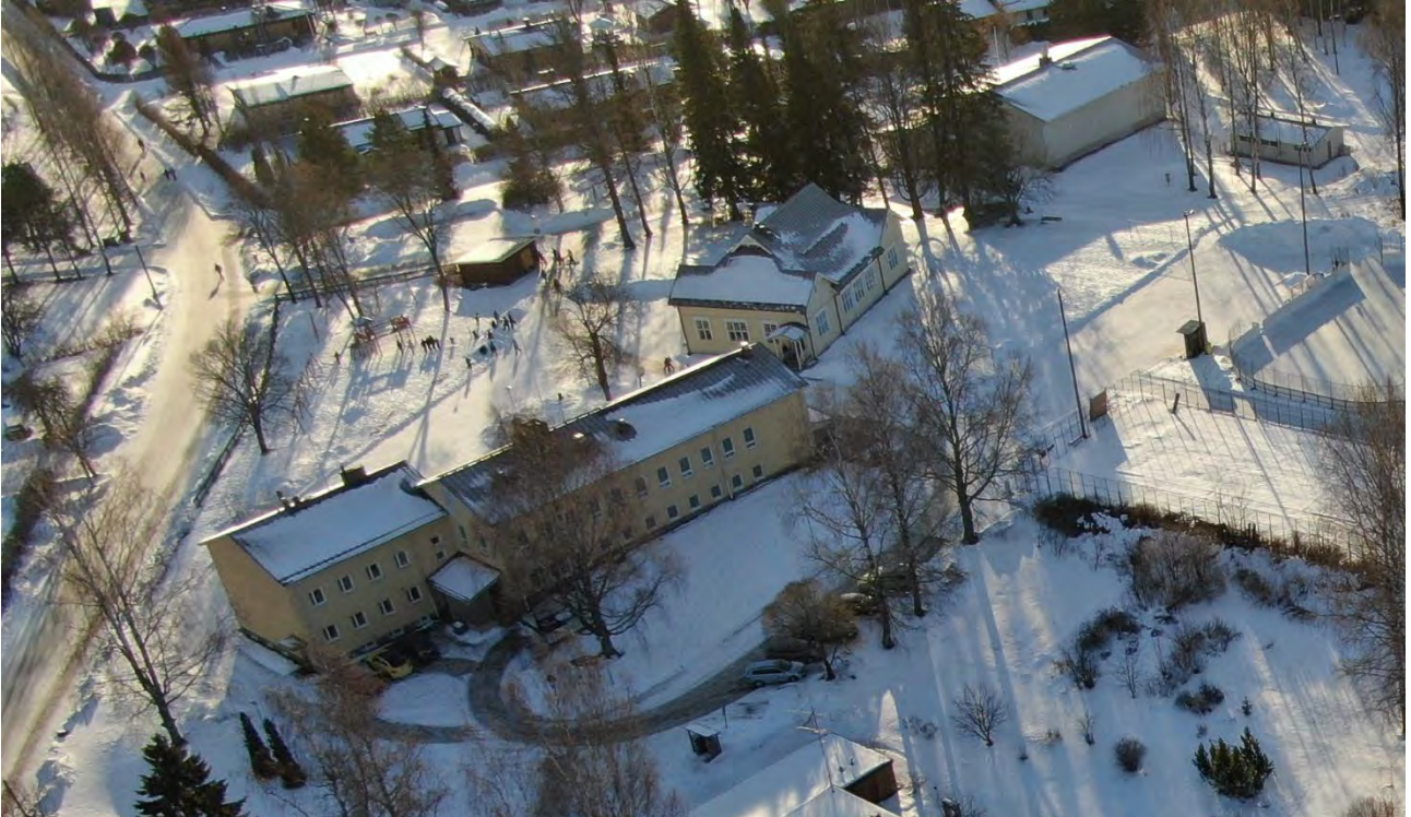
Luopioisten kirkonkylän koulurakennukset. Taaempana vuonna 1910 rakennettu kansakoulurakennus, etualalla vuonna 1954 rakennettu koulu.
