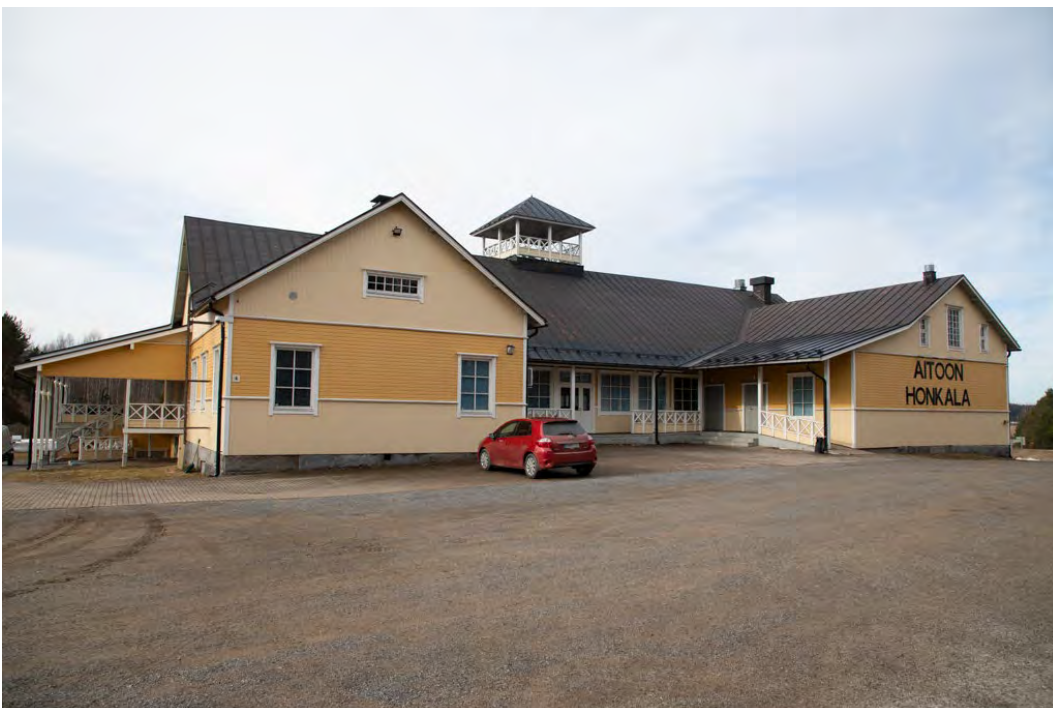
Aitoon vuonna 1915 rakennettu koulurakennus.
