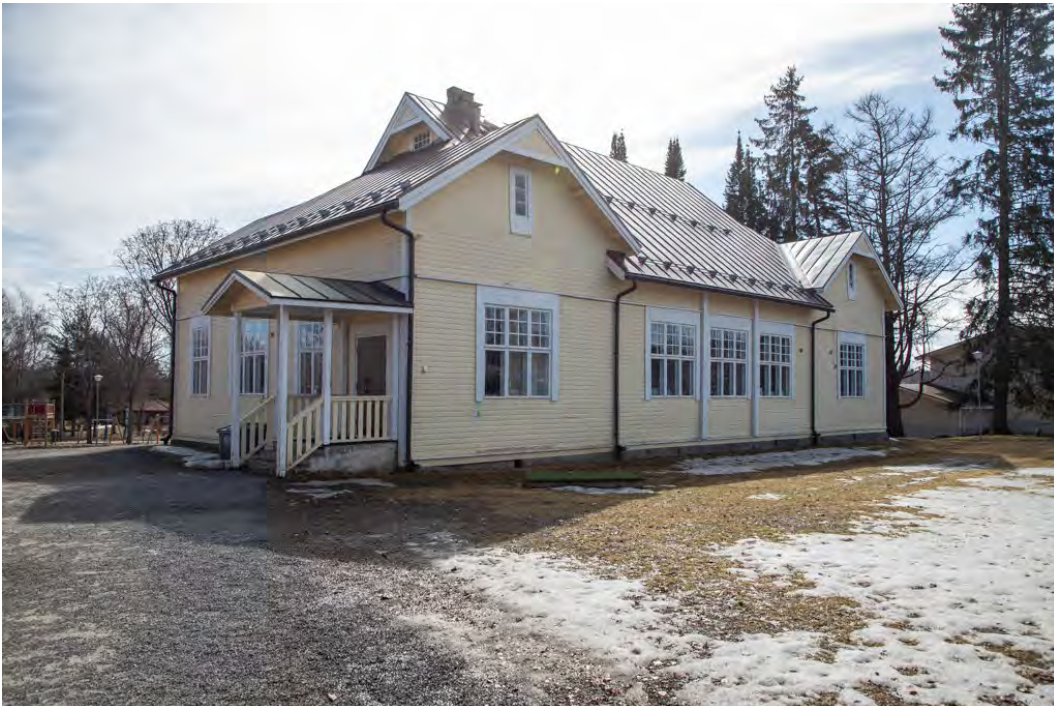
Luopioisten vuonna 1910 rakennettu koulurakennus.
