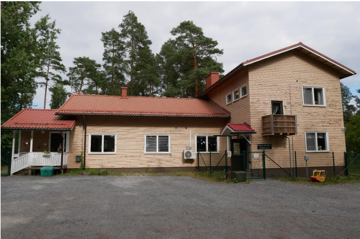
Rakennuksen julkisivu Syrjänharjuntien puolelta. Valokuva: Pälkäneen kunta.
