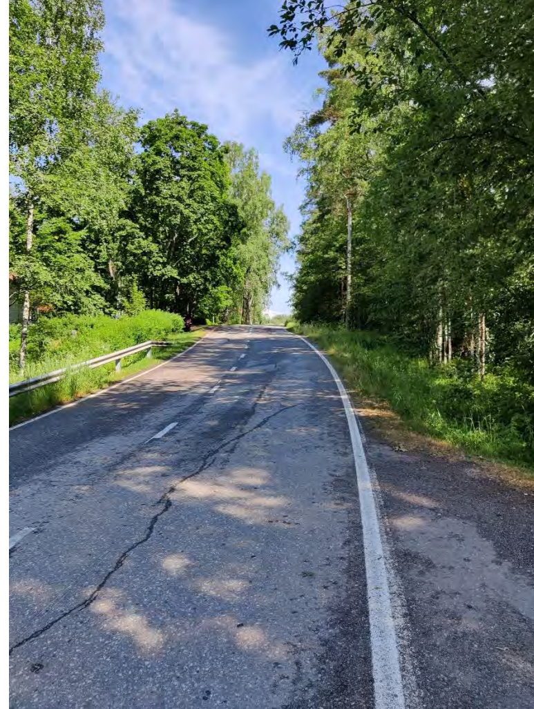
Kuva 17. Keskitie Väinönväylän kohdalla
