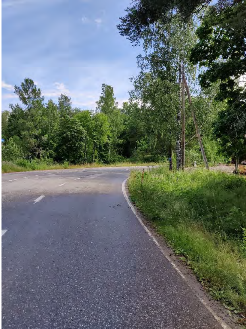
Kuva 10. Keskitie 18:n kohdalla
