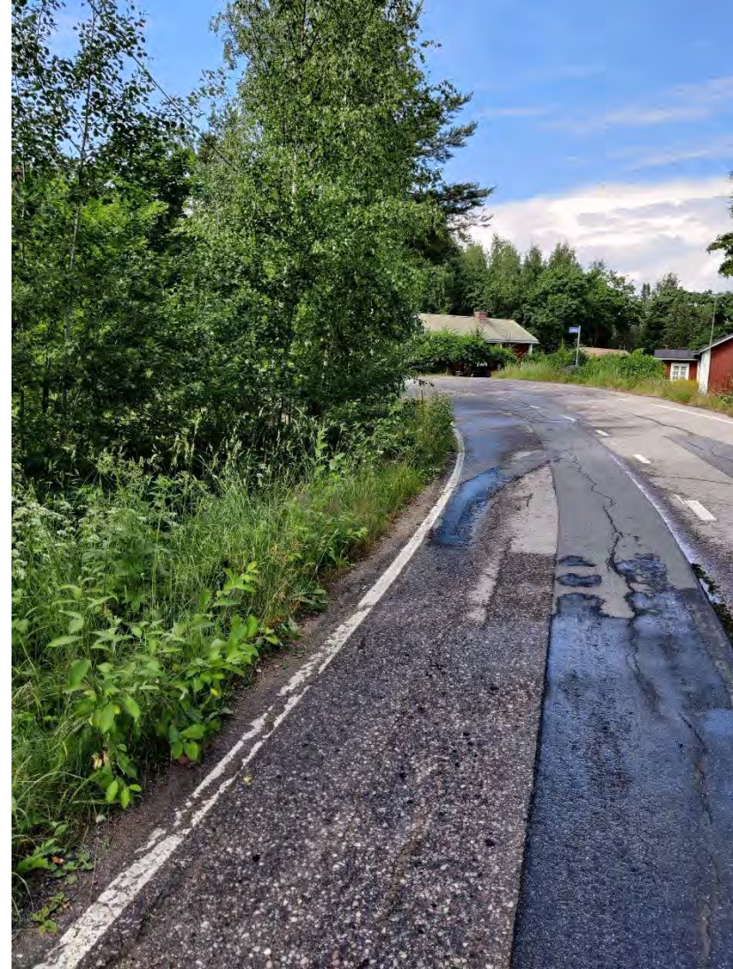
Kuva 11. Keskitie 18:n kohdalla
