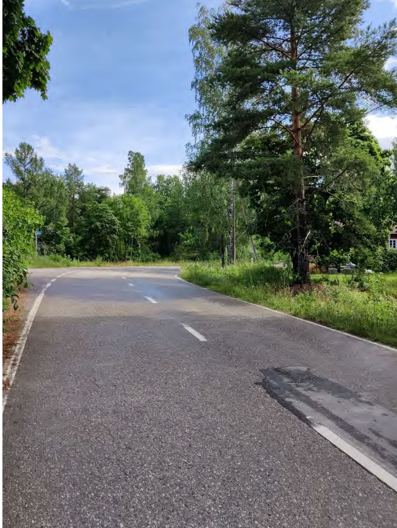
Kuva 12. Keskitie 18:n kohdalla
