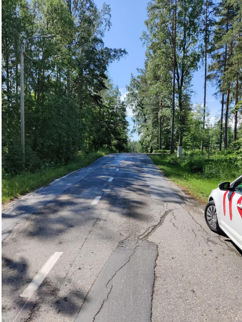
Kuva 16. Keskitie Väinönväylän kohdalla (kohtaamisnäkemä pienimmillään 68 m)
