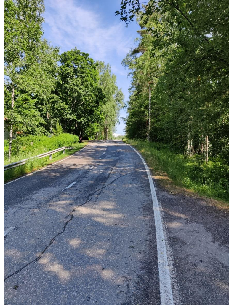
Kuva 17. Keskitie Väinönväylän kohdalla
