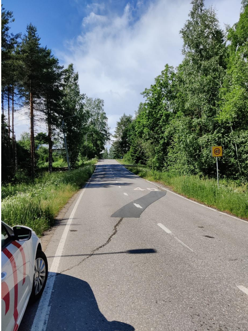
Kuva 14. Keskitie litainpolun kohdalla (kohtaamispääty pienimmillään 48 m)
