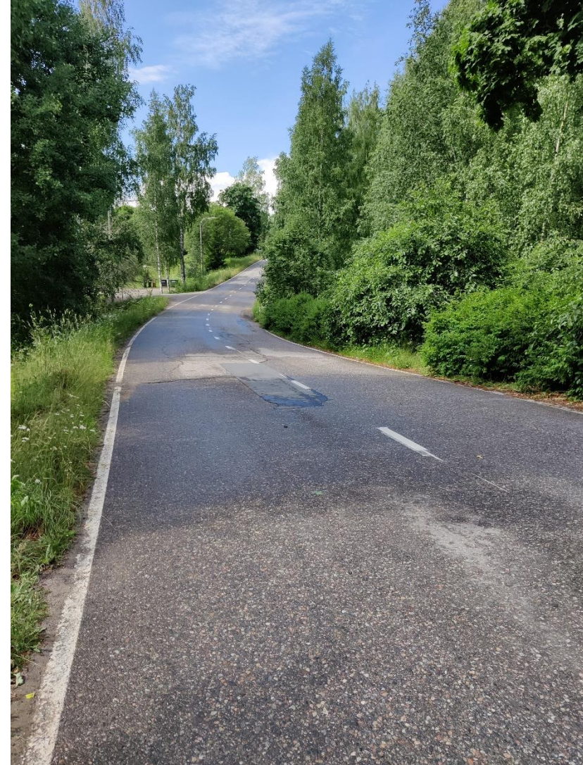
Kuva 13. Keskitie 18:n kohdalta länteen
