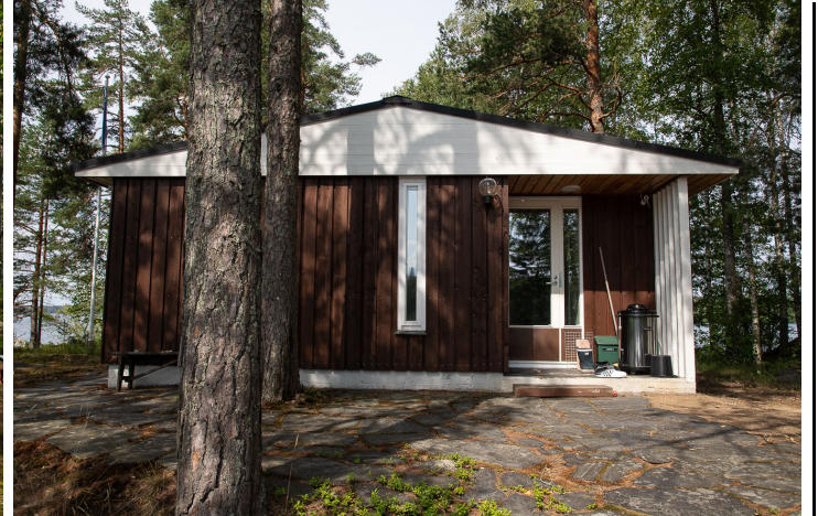
Asuinrakennuksen kaakkoispääty, jossa on vuonna 1991 tehty laajennus.
