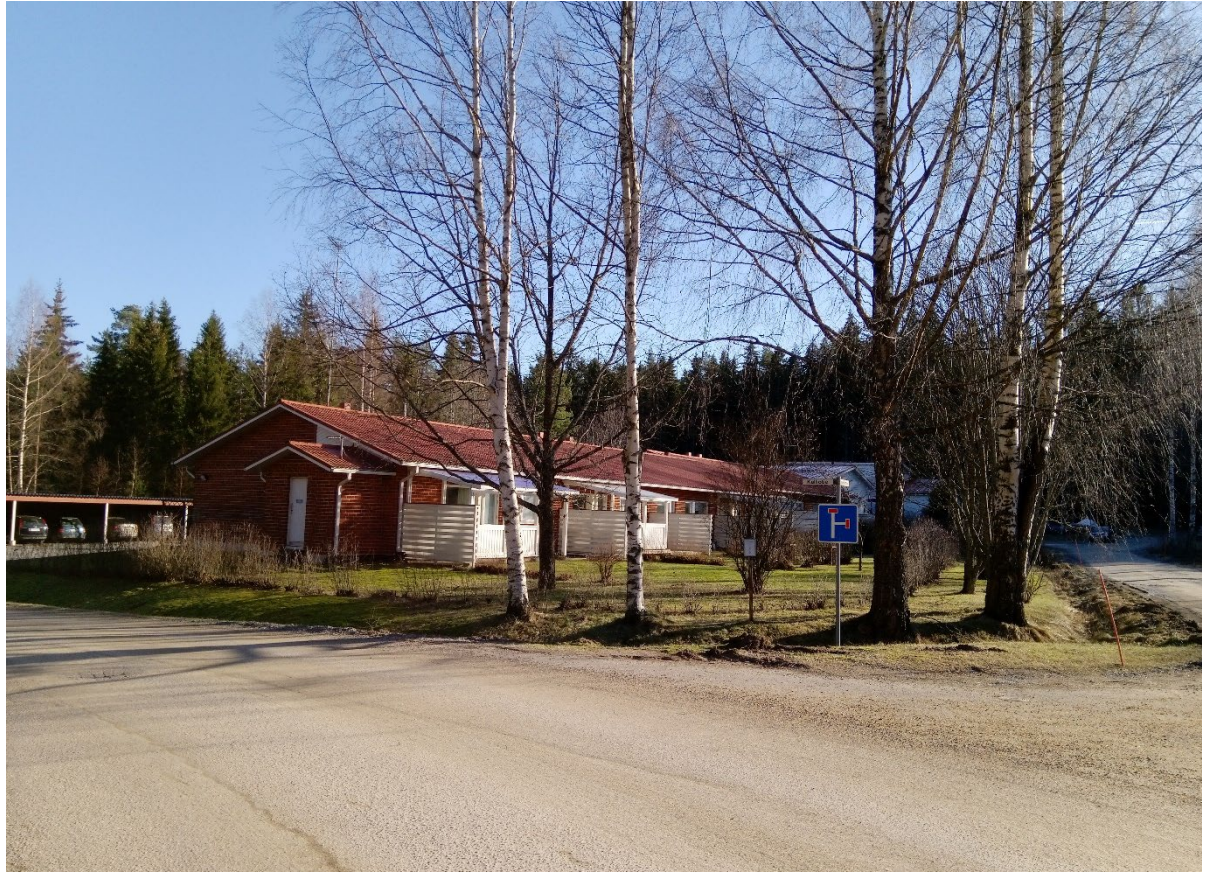
Rivitalo Lastenlinnantien ja Kalliotien risteyksessä. Kuva: Minna Aittola.
