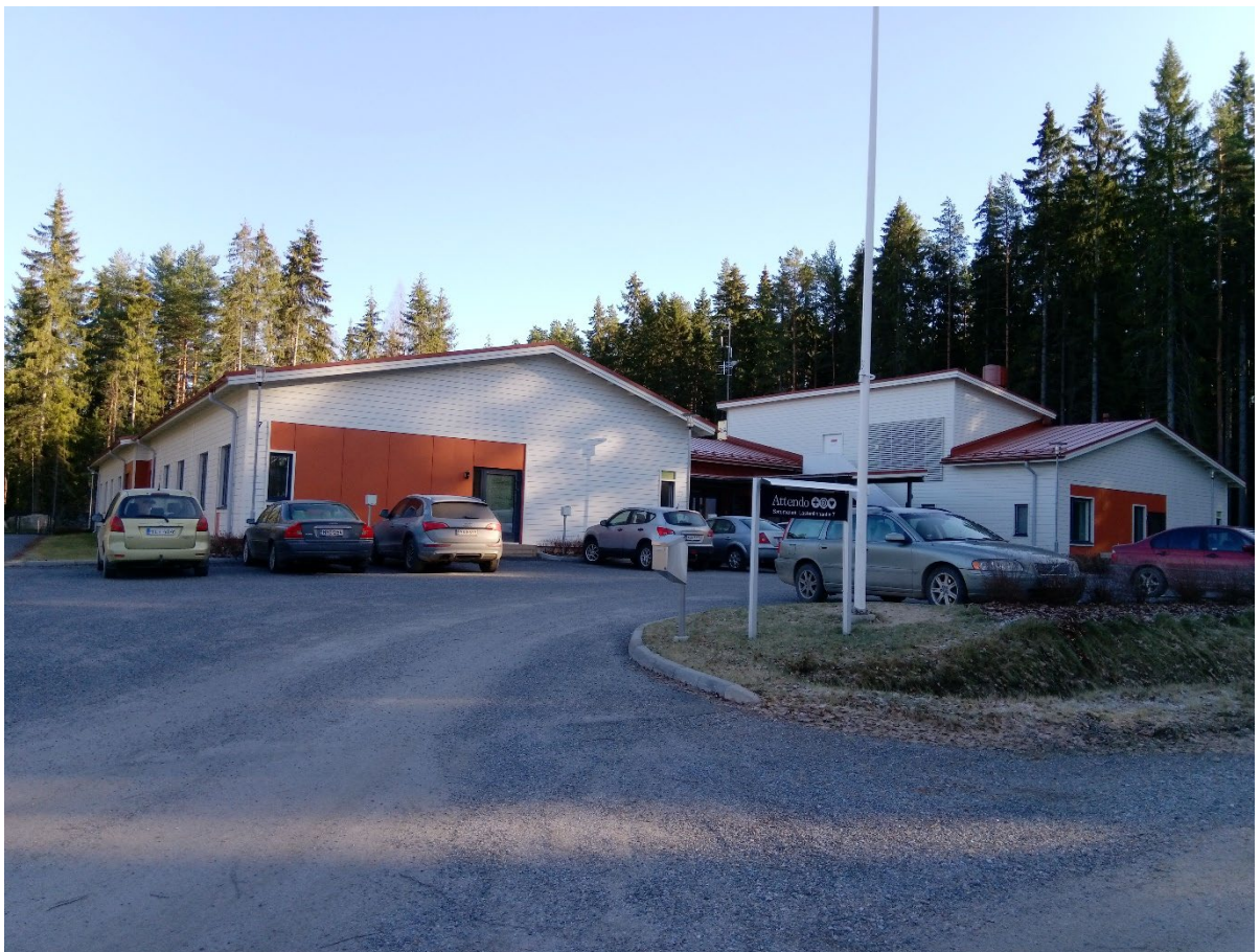
Hoivakoti Attendo Satumetsä Lastenlinnantien varrella. Kuva: Minna Aittola.
