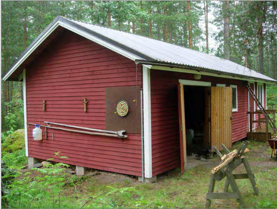
Kuva 37. Talousrakennus kuvattuna lounaasta. Avoin ovi johtaa liiteriin ja työkaluvarastoon.
