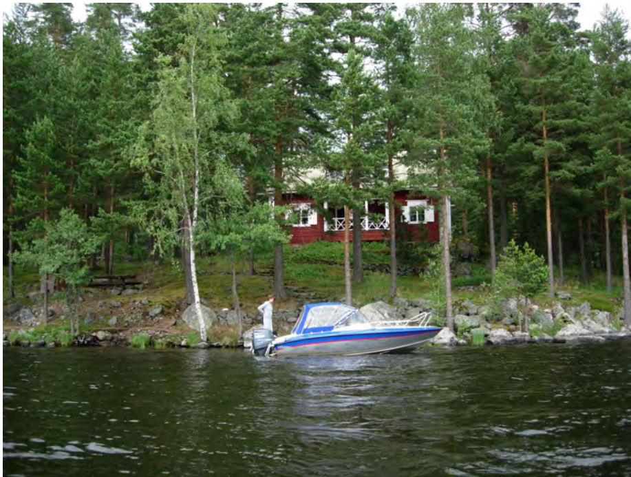
Kuva 22. Kuva Kukkiajärveltä kohti päärakennusta. Kuvattu lounaasta.
