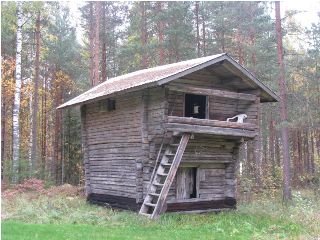
Kuva 13. Kukkiasaaren vanhan rakennuspaikan aittarakennus.
