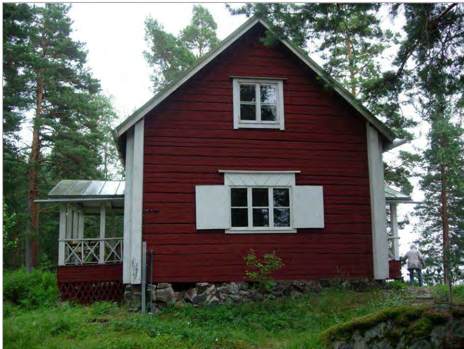
Kuva 20. Rakenuksen pohjoispääty. Kuvattu luoteesta.
