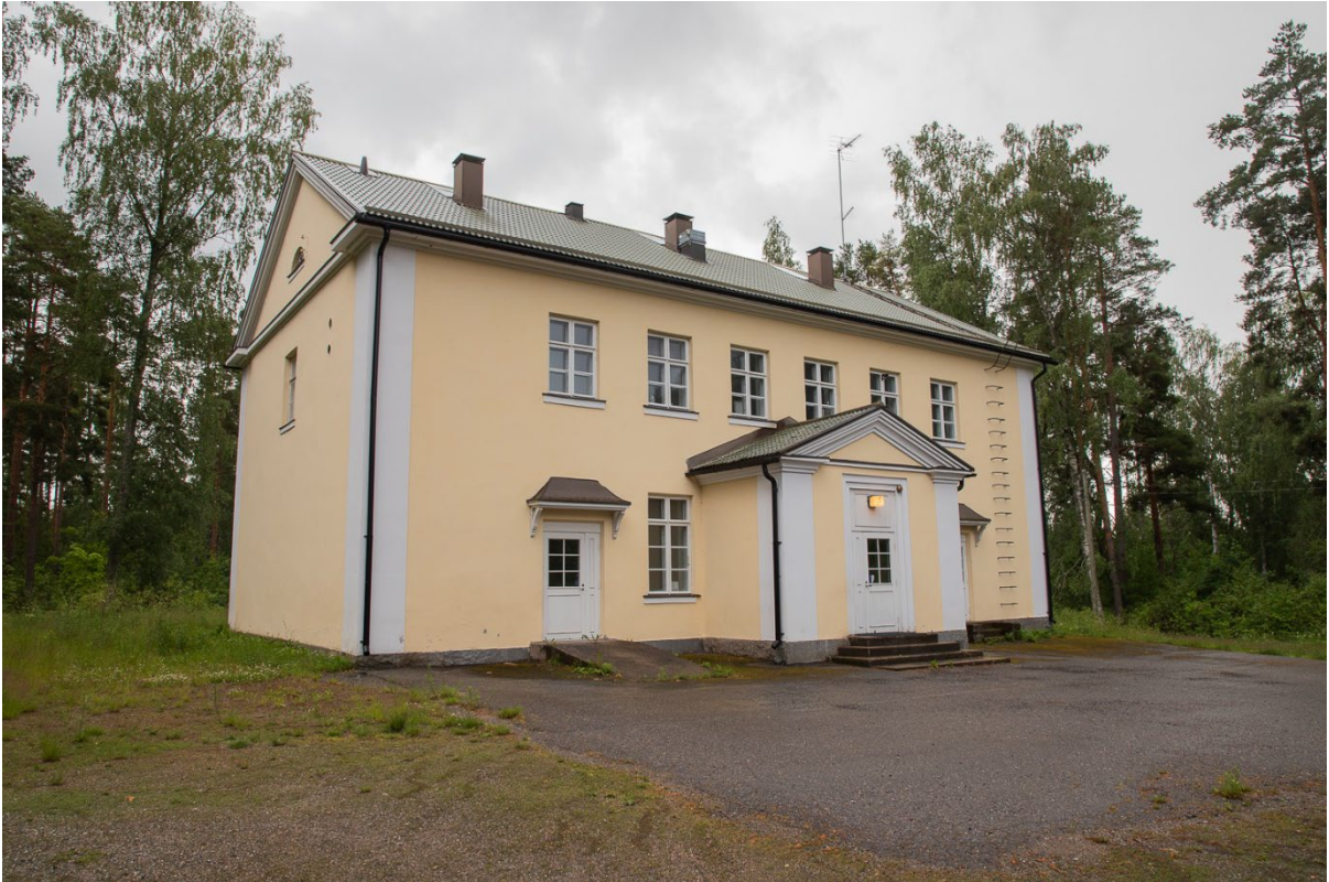
Harhalan koulun päärakennus.
