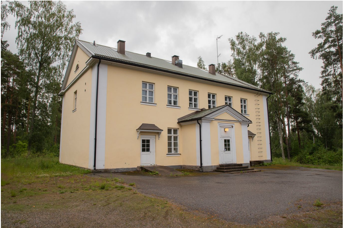
Harhalan koulun päärakennus.
