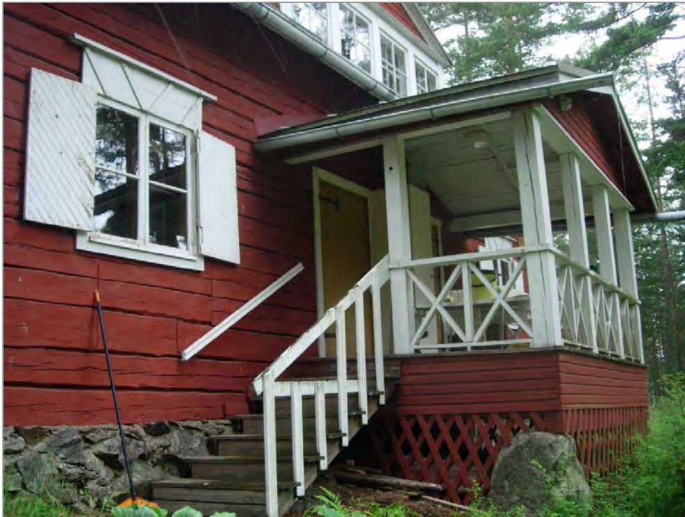
Kuva 18. Rakennuksen itäinen, metsänpuoleinen avokuisti. Alunperin portaat ovat kulkeneet kivistä itäisivulta kohtisuoraan pois talosta. Portaiden paikka on muutettu todennäköisesti jo 1930-luvulla Anton Selinin johdolla. Kuvattu kaakosta.
