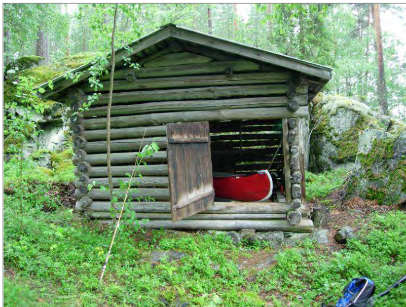
Kuva 40. Verkkovaja kuvattuna länsilounaasta.
