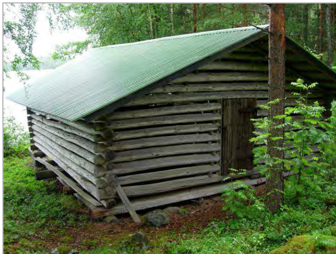
Kuva 44. Venesuoja kuvattuna kaakosta.
