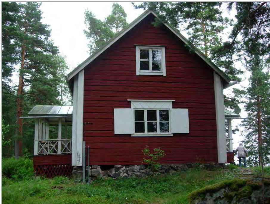
Kuva 20. Rakenuksen pohjoispääty. Kuvattu luoteesta.
