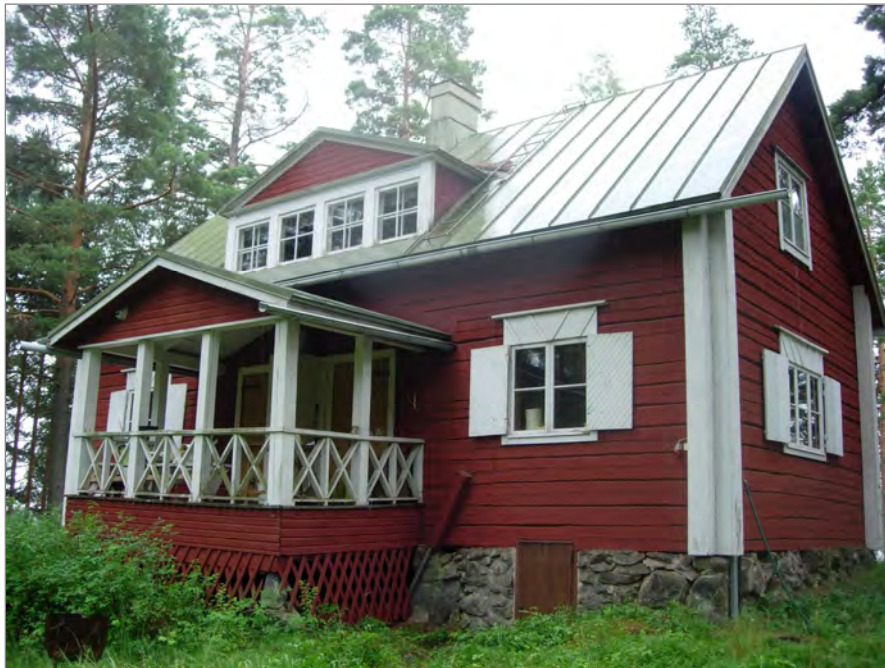
Kuva 19. Itäinen eli metsänpuoleinen julkisivu. Kuvattu koillisesta.
